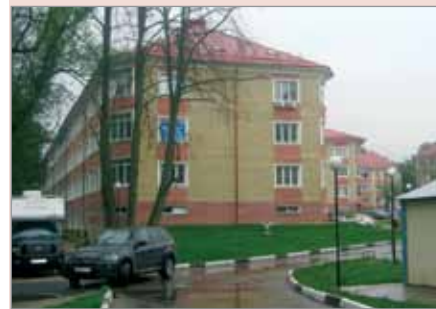
Жилой микрорайон в Московской области. Общая мощность систем тепловых насосов — 1,2 МВт.
