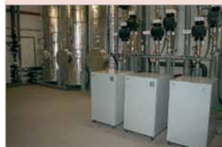
Система из трех тепловых насосов в каскаде.
