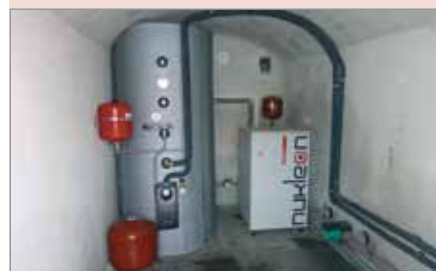
Индивидуальный тепловой пункт с тепловым насосом.
